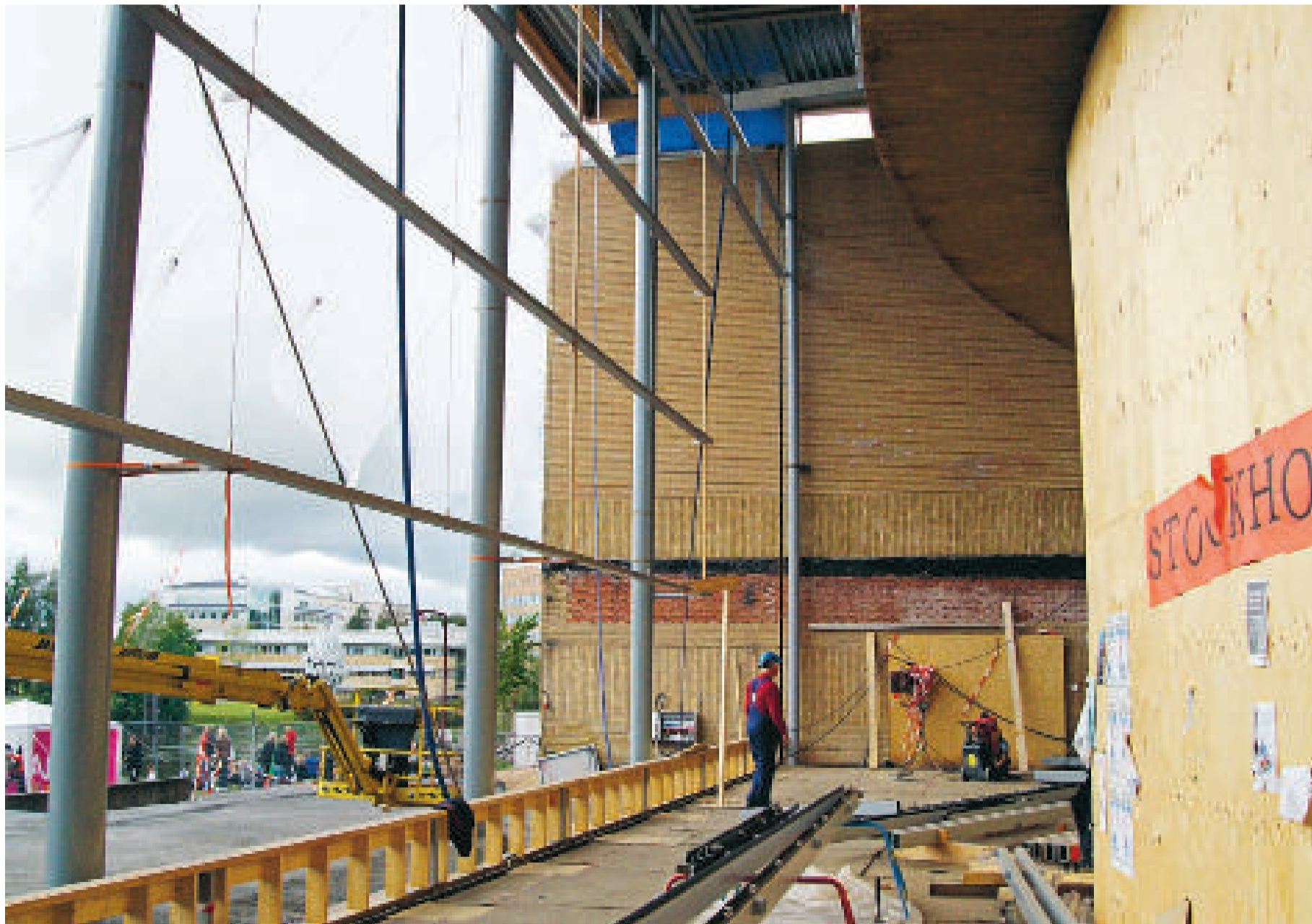
Mählers Smide, med 20-talet anställda och egen CAD-konstruktion erbjuder kunderna bygg-/industrismide och stålkonstruktioner, från behov till färdigt platsmontage.
